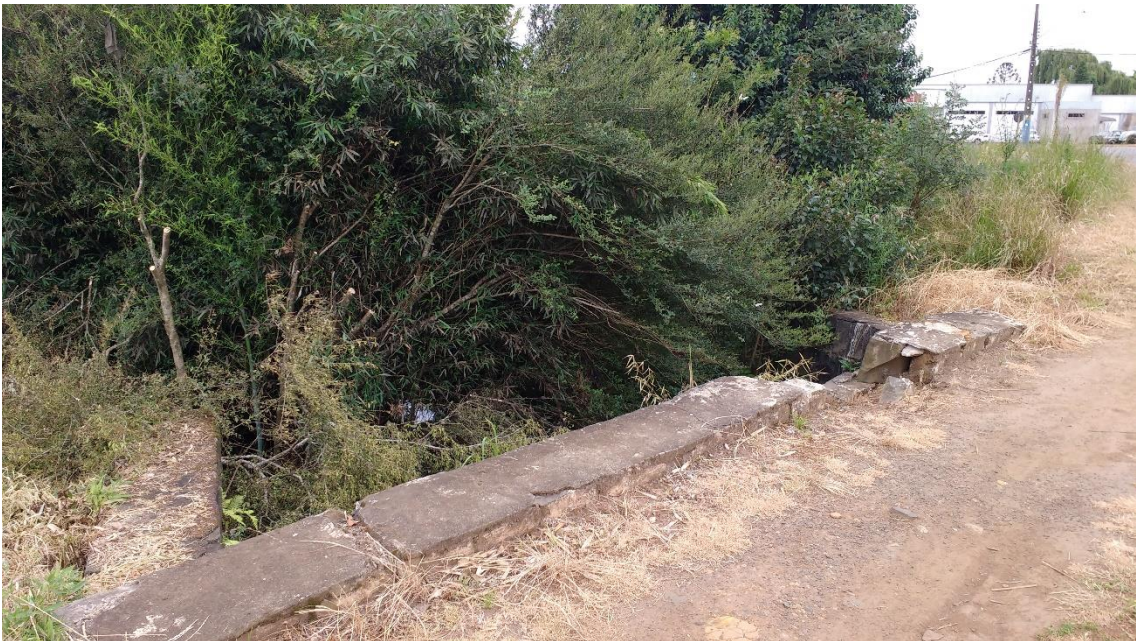
Encontro do Córrego com a Rua Nossa Senhora da Luz – 2 – 27°19'43.3"S 50°28'08,4"W Obra de Prevenção: Execução de Galeria em Concreto Armado
