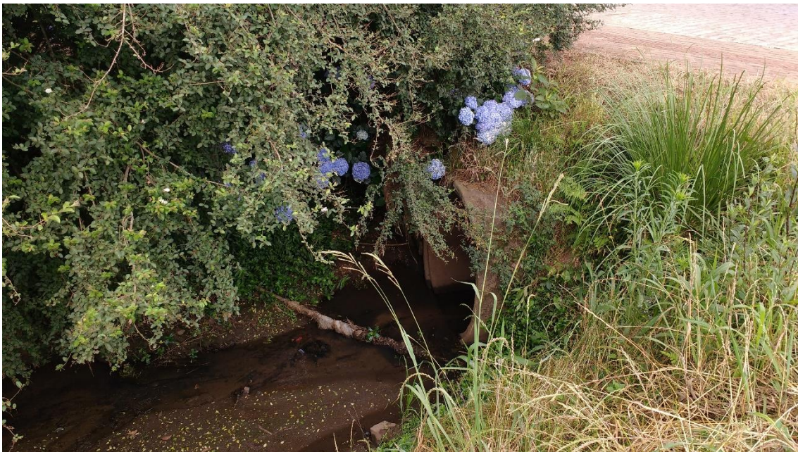
Encontro do Córrego com a Rua Santa Catarina (Montante) –2– 27°09'39.9"S 50°28'09.3"W Obra de Prevenção: Execução de Galeria em Concreto Armado
