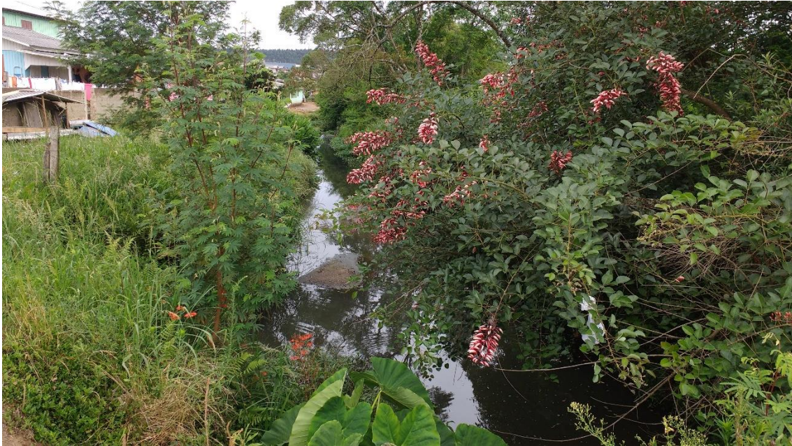
Encontro do Córrego com a Rua Santa Catarina (Jusante) – 1 – 27°09'39.3"S 50°28'09.0"W Obra de Prevenção: Execução de Galeria em Concreto Armado
