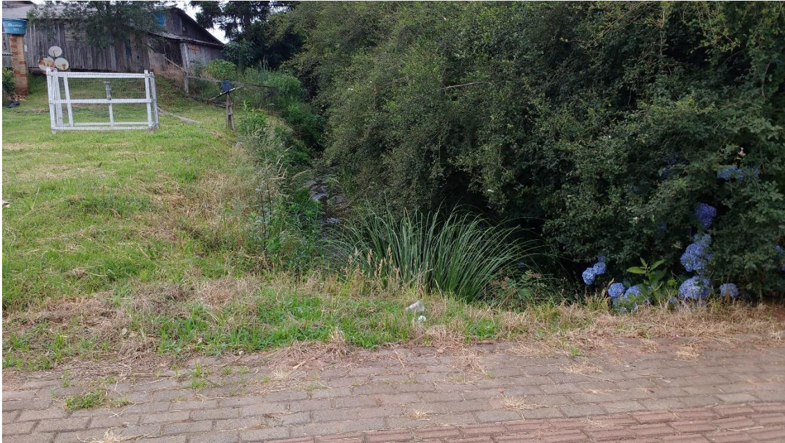
Encontro do Córrego com a Rua Santa Catarina (Montante) –1– 27°09'39.9"S 50°28'09.3"W Obra de Prevenção: Execução de Galeria em Concreto Armado
