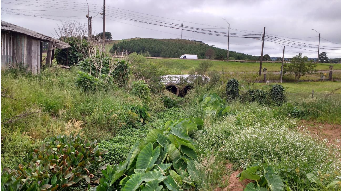
Encontro do Córrego com a Rua Marginal a BR 116 – 1 – 27^{\circ}09'36.9''\text{S} 50^{\circ}28'00,6''\text{W} Obra de Prevenção: Execução de Galeria em Concreto Armado
