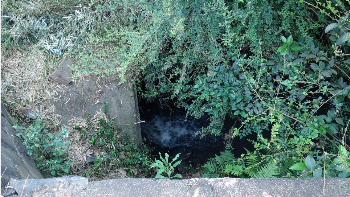
Encontro do Córrego com a Rua Nossa Senhora da Luz – 1 – 27°19'43.3"S 50°28'08,4"W Obra de Prevenção: Execução de Galeria em Concreto Armado
