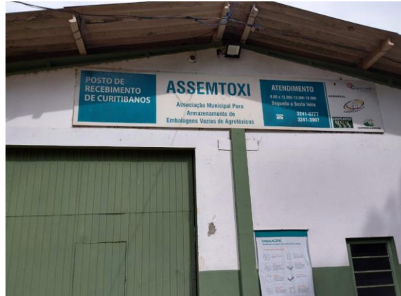
Figura 29 - Galpão da ASSEMTOXI.
