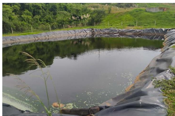
Figura 36 - Manta impermeável da lagoa de estabilização de forma regular.
