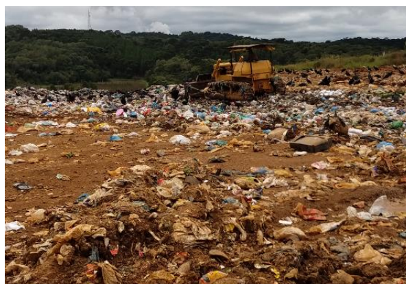
Figura 40 - Trator realizando a compactação.
