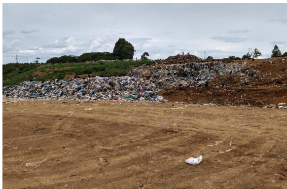
Figura 34 - Aterro Sanitário - Visita realizada no dia 02/02/2021.
